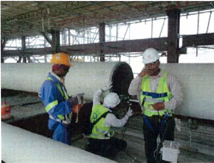
管内の状況をモニターで確認
